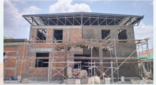
▲ 金邊堂建堂工程進行中
