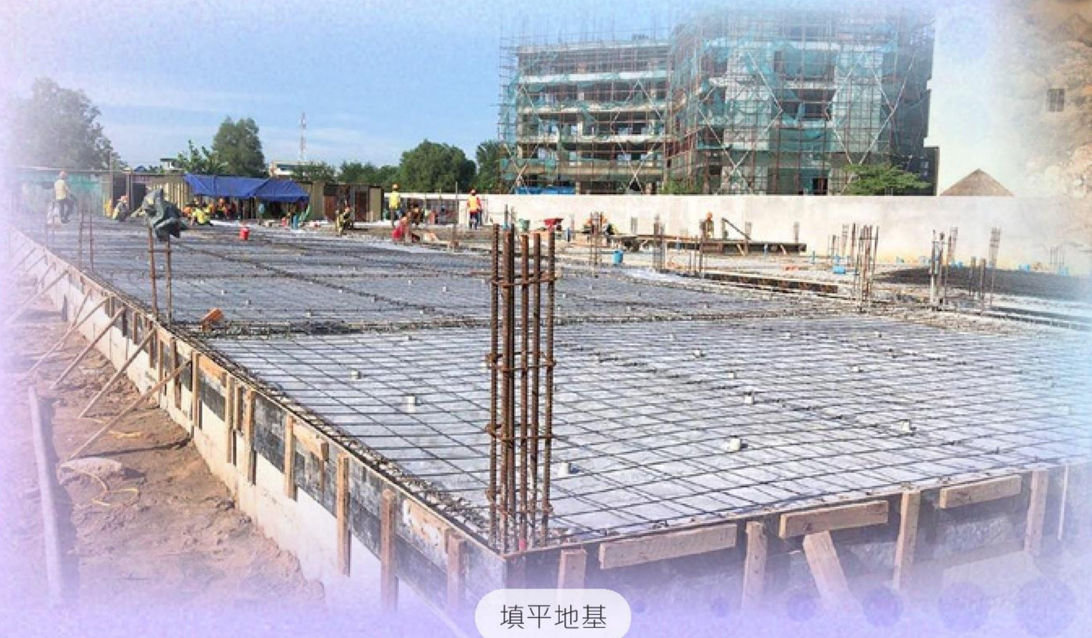
停雨後，抽乾水注入混凝土
