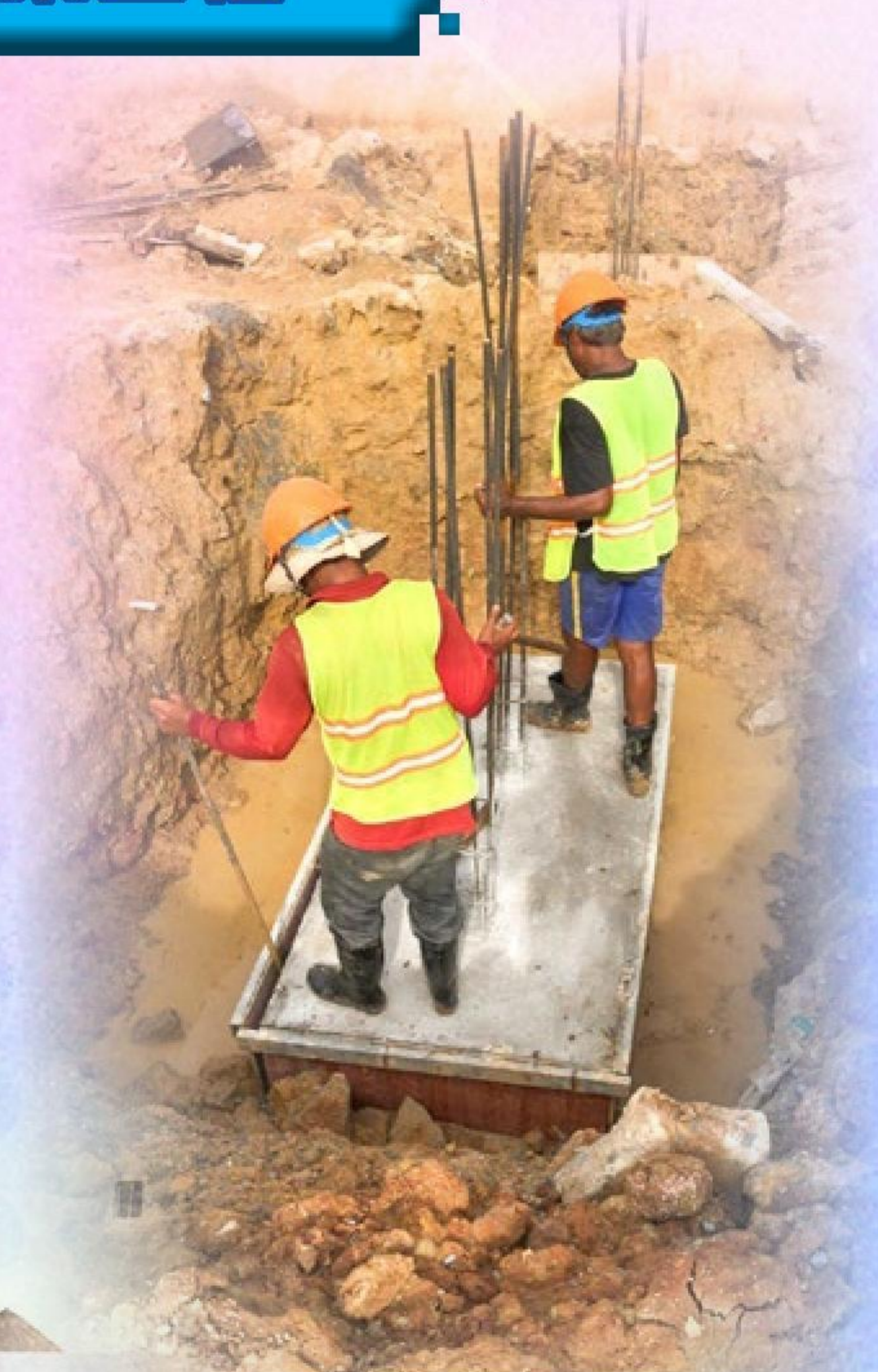
停雨後，抽乾水注入混凝土
