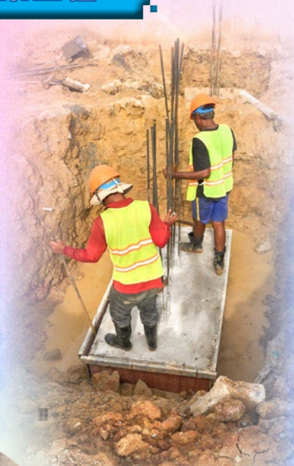
停雨後，抽乾水注入混凝土
