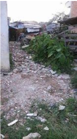
社區修路工程
